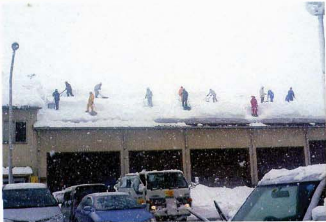
▲降り続く雪にもまげず作業中!!
